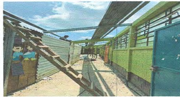
Foto 3: Instalación de costaneras en el interior de la escuela
