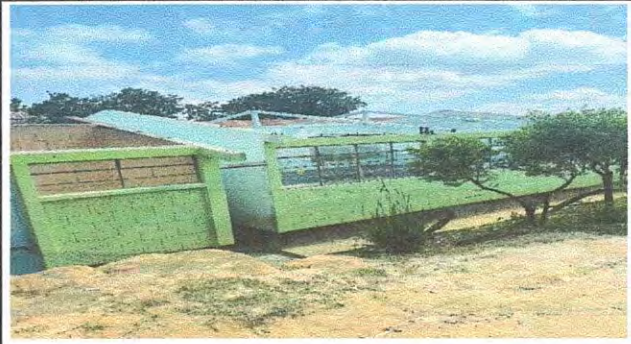
Foto 2: Instalación de costaneras bodega y cocina
