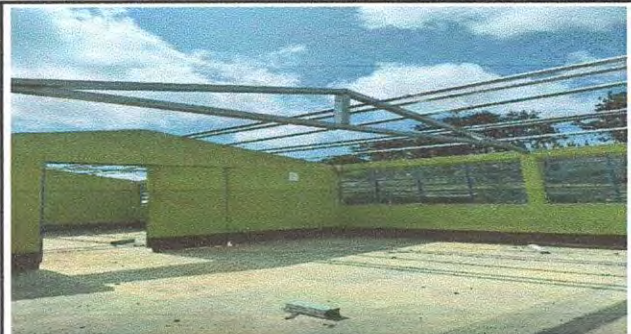
Foto 6: Instalación de costaneras interior aulas
