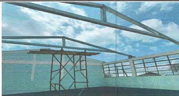
Foto 5: Instalación de costaneras interior aulas
