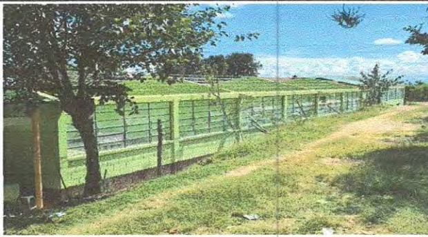
Foto 1: Quitado de techo e instalación de costaneras
