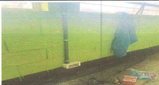
Foto 5: Instalación y cambio de tomacorrientes
